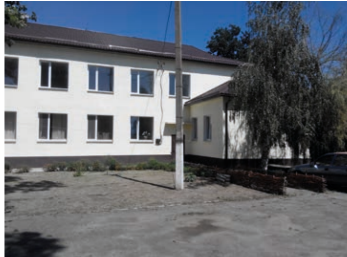
Запорізька область, смт Новомиколаївка, вул. Шкільна, 92
